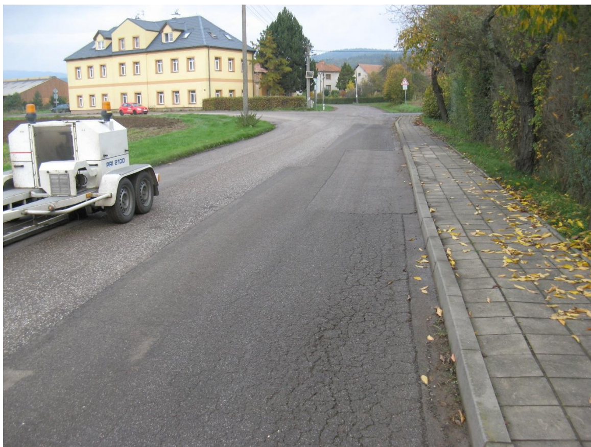
F61, km 2,960- (III/2864) Síťové trhliny a vysprávký.
