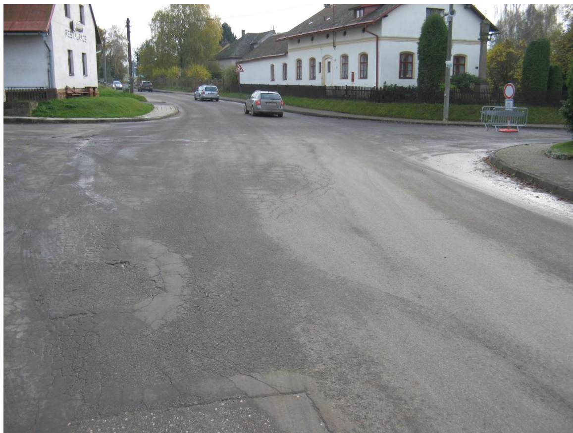
F70, km 3,360+ (III/2864) Síťové trhliny a vysprávký na části s opraveným povrchem.
